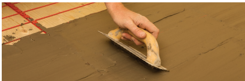
FIGURE 2.52 : Méthode du mortier à pose simplifiée
