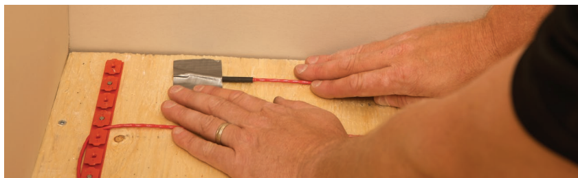
FIGURE 2.28: Fixer l'embout protecteur
