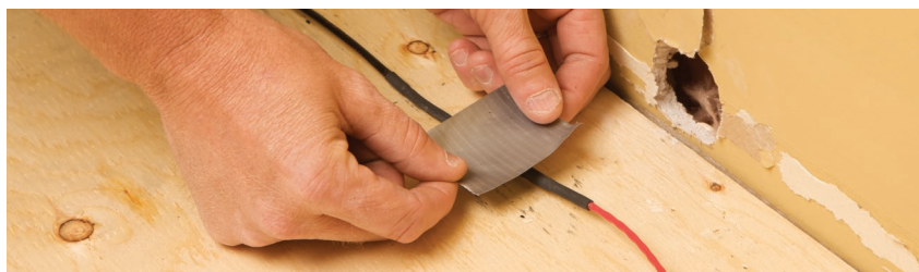
FIGURE 2.23 : Fixer le conducteur froid au faux plancher
