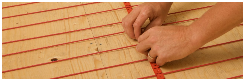
FIGURE 2.29 : Installer les guides de stabilisation
