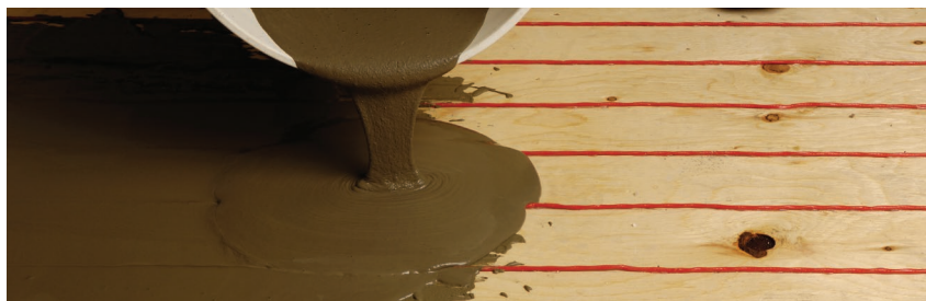
FIGURE 2.42 : Méthode du mélange autolissant
